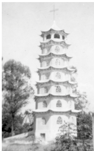
圖 30：這七層高塔是為營造可以媲美歌德式的高塔，同時又塑造中式的宗教建築模樣，塔頂層懸掛古鐘，頂尖處樹立十字架，塔具備水箱和發電機功能
